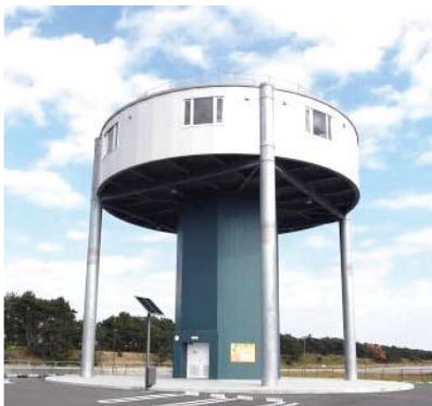
磐田市津波避難タワー
